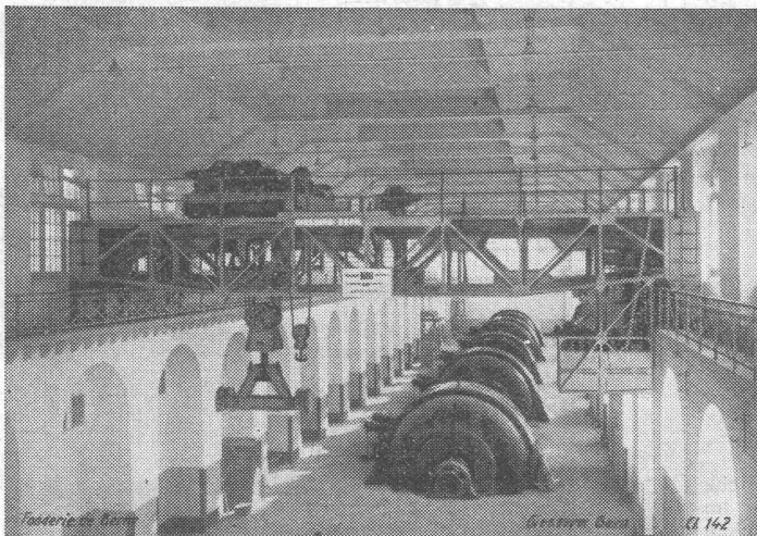
100 Tonnen Laufkran mit Lasttraverse in der Zentrale Amsteg der S. B. B.
