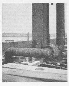
Abb. 3. Befestigung der äussern Korkschalen-Schutzhülle über den Heizkabeln.
