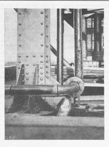
Abb. 2. Heizkabel-Befestigung an einer Kaltwasser-Leitung.
