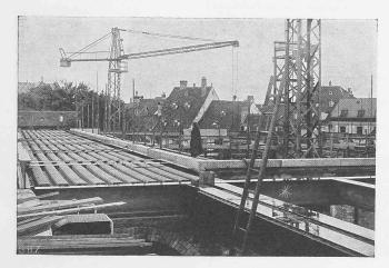
Abb. 6. Deckenkonstruktion aus Eisengebälk mit Hohlsteinen.
