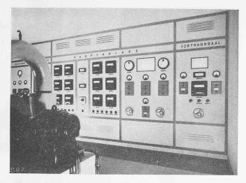
Abb. 2. Zentrale Schalttafel der Luftkonditionierungs-Anlage.
