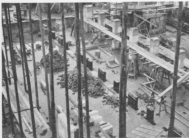
Abb. 9. Baubild mit den aufsteigenden Lüftungskanälen.
