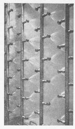
Abb. 4. Inneres des Luftwaschers (Raum D in Abb. 3).
