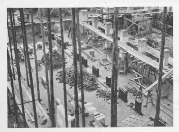
Abb. 9. Baubild mit den aufsteigenden Lüftungskanälen.
