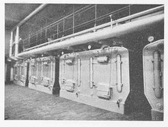
Abb. 1. Kesselzentrale, sieben Sulzer Grosskessel, 310 m² Heizfläche.
