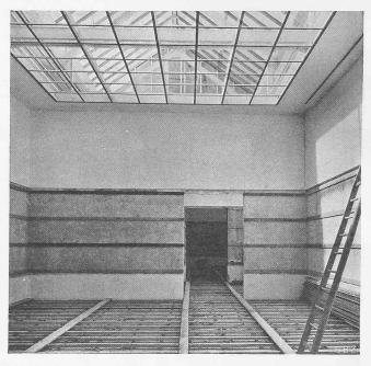
Abb. 8. Kleiner Oberlichtsaal; Zwischenwände aus Gipsdielen.
