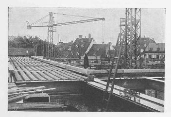
Abb. 6. Deckenkonstruktion aus Eisengebälk mit Hohlsteinen.
