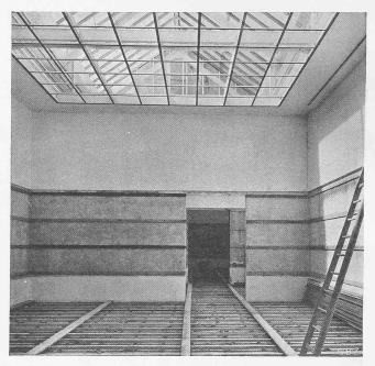
Abb. 8. Kleiner Oberlichtsaal; Zwischenwände aus Gipsdielen.
