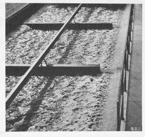
Abb. 5. Abwasser-Reinigungsanlage eines Schlachthofes, nach Kessener.
