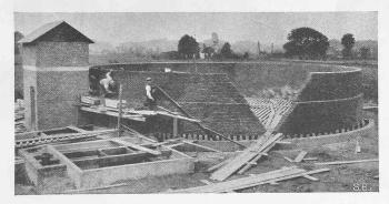
Abb. 2. Bau eines Tropfkörpers (Drainageboden sichtbar).
