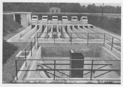
Abb. 3. Belüftungsanlage für Schlammbelebung nach Haworth (Schlagräder).
