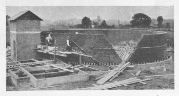
Abb. 2. Bau eines Tropfkörpers (Drainageboden sichtbar).
