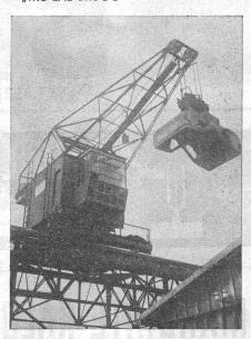
Verwendung v. Draht-seilen in Greifer-Kranen.
