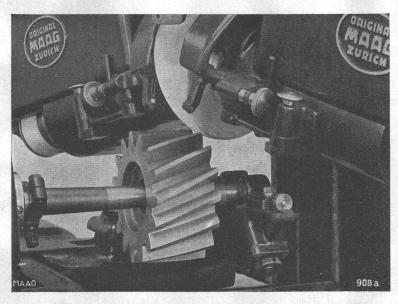
MAAG-ZAHNRADSCHLEIFMASCHINE für Stirn- und Schraubenverzahnung
