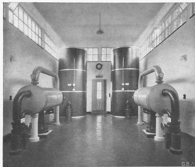
Abb. 6. Apparatenraum: Gegenstromapparate und Boiler. Hohes Seitenlicht (über Werkstatt Dach).
