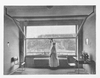
Abb. 28 und 29. Decken-Schiebefenster System Seeger, Einzelheiten 1:30 und Betätigung.
