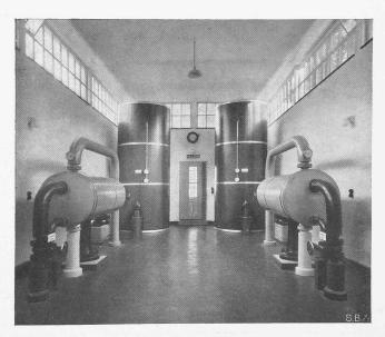
Abb. 6. Apparateraum: Gegenstromapparate und Boiler. Hohes Seitenlicht (über Werkstattdach).
