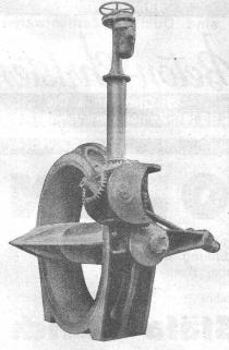
Drosselklappe 3000 mm Nennweite mit elektro-motorischem und mit Handantrieb. seit mehr als 50 Jahren
