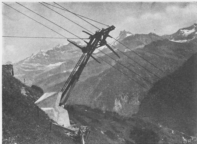
Abb. 2. Stütze der Luftseilbahn Spiringen-Ratzismatt am Klausen.
