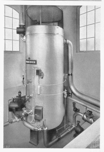
Abb. 6. Hochspannungs-Elektro-Dampfkessel für 16 atü, Spannung 10 kV, Leistung 2200 kW. Brauerei Falken, Schaffhausen (mit Dampfspeicher von 76  $\rm m^3$  Inhalt).
