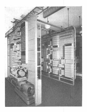
Wir erstellen Telephonanlagen jeder Art und Größe. Die Abbildungen zeigen die Telephonanlage der Eidg. Technischen Hochschule, bestehend aus dem Vermittlerschrank für 16 Leitungen für den Verkehr mit der Stadt (unten) und dem Automaten für 400 Teilnehmer (oben).
