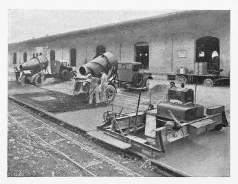
Abb. 4. Bau einer Betonstrasse am Güterbahnhof Zürich.
