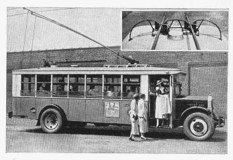
Abb. 7. Erste Versuchsausführung eines Zweikraft-Trolleybus in Newark, N. J. — Oben rechts automat. Fangvorrichtung für Fahrt
