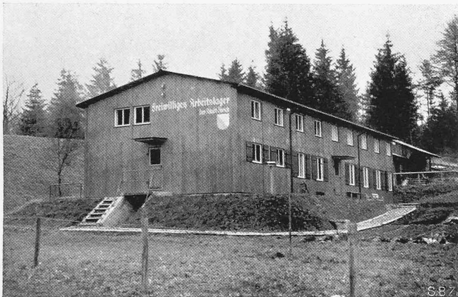
Abb. 7. Wohnbaracke Waldegg. Arch. R. WINKLER, Zürich
