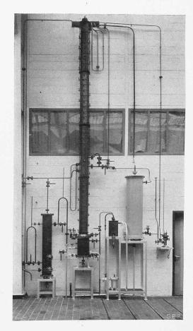
Abb. 16. Rektifikations-Anlage zur Trennung von Wasser und Alkohol.
