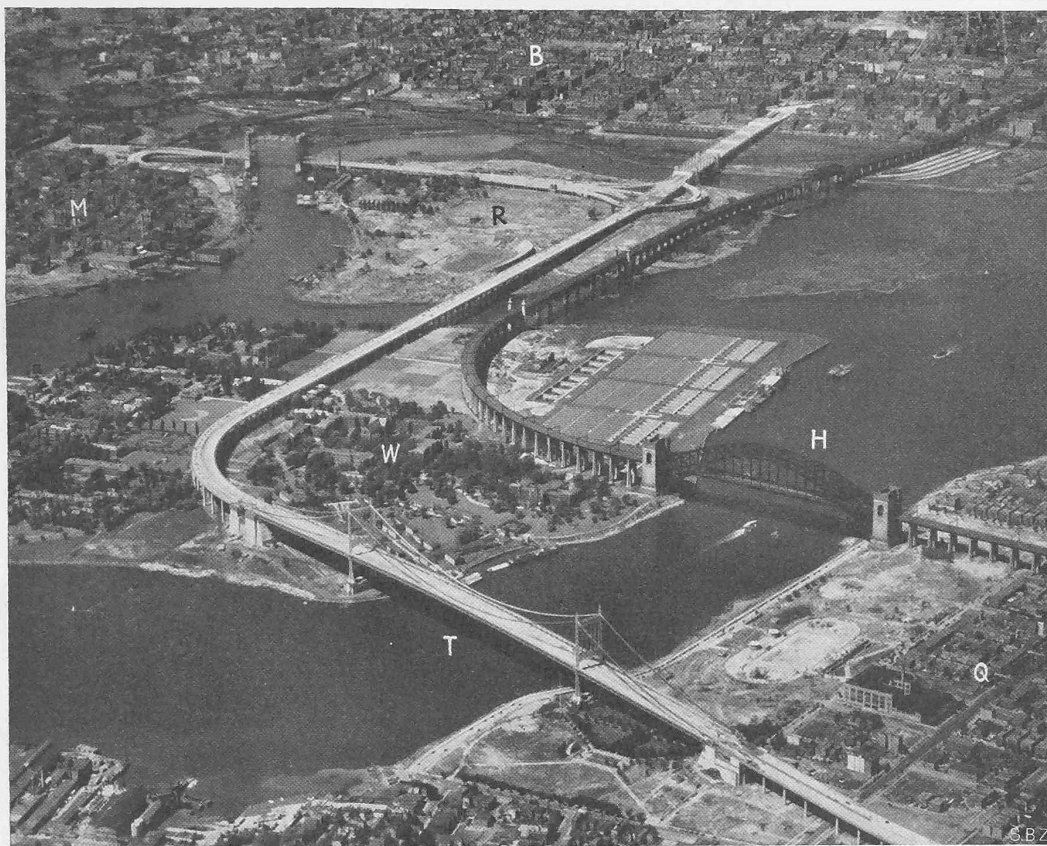
Abb. 1. Triborough Bridge in New York. Flugbild aus Süden. — Phot. Mc Laughlin Aerial Surveys. Legende: B Stadtteil Bronx, M Manhattan, R Randalls Island, W Wards Island, T Triborough Brücke, Q Queens, H Hellgate-Eisenbahnbrücke (siehe «SBZ» Band 66, S. 181* und 307*).
