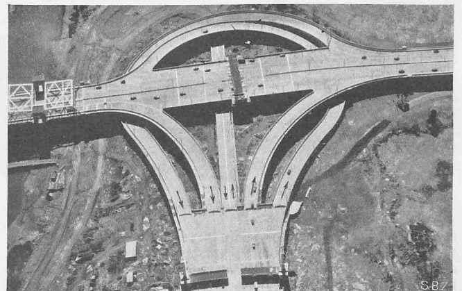
Abb. 7. Das grosse Strassenanschluss-Bauwerk auf Randalls Island.
