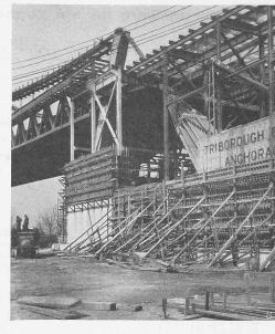
Abb. 4. Verankerung der Triborough Bridge auf der Seite von Queens. — Abb. 4 und 6 phot. H. Krenn.
