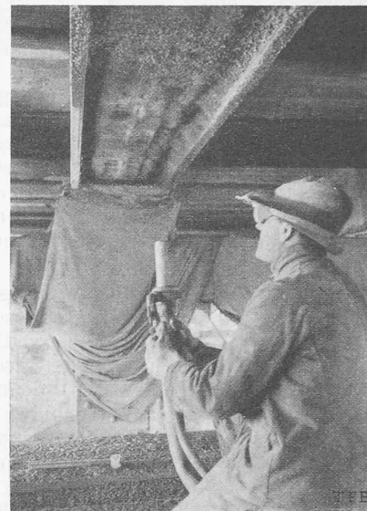
Abb. 3. Gunitieren eines Unterzuges.
