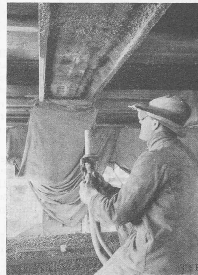
Abb. 3. Gunitieren eines Unterzuges.
