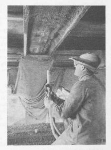
Abb. 3. Gunitieren eines Unterzuges.
