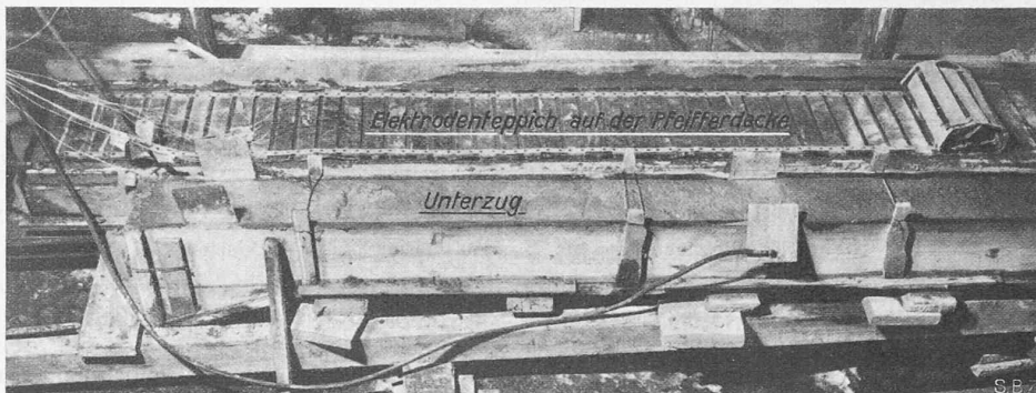
Abb. 6. Elektrische Betonerwärmung zweier Versuchstücke: hinten Pfeifferdecke mit Elektroden-teppich, davor Unterzug mit Seitenblechen, deren Sekundärkabel deutlich sichtbar sind. Die dünnen Kabel dienen für elektrische Temperaturmessung.
