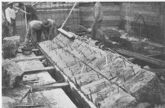
Abb. 11. Nadelerwärmung in dessen Mauerwerksfugen.
