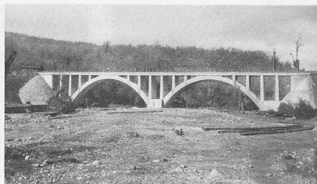
Abb. 11. Eisenbetonbrücke über den Talar, Km. 145,5, 2 Öffnungen zu 30 m.
