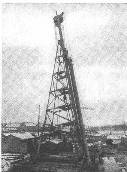
Verwendung von Stahldrahtseilen in Rammen.
