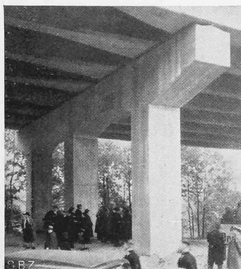
Abb. 15 und 16. Saubachbrücke bei Wilsdruff. Durchlaufender Eisenbetonbalken auf Eisenbeton-Rahmenpfeilern, 262 m lang, Fahrbahn 24 m breit.
