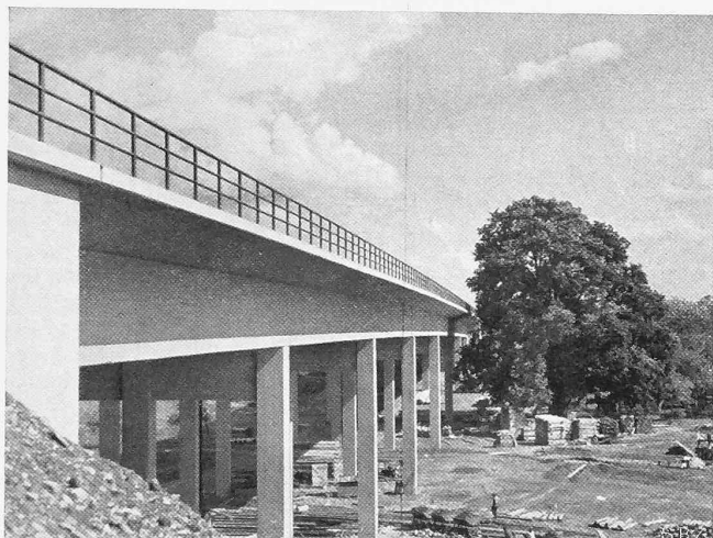
Abb. 12. Talübergang bei Denkendorf. Entwürfe Ob. Bauleitung Stuttgart (Phot. Hudelmaier). Durchlaufende Eisenbetonträger mit einem Gerber-Mittelträger.
