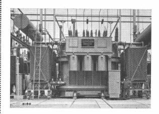
ENTREPRISES ELECTRIQUES FRIBOURGEOISES Freiluft-Transformatoren-Station Hauterive. - Dreiphasen-Transformator 22 000 kVA, 127 auf 61  $\pm$  10 imes0,9 KV, 50 Pér., mit Stufenschalter unter Last; natürliche Oelkühlung.
