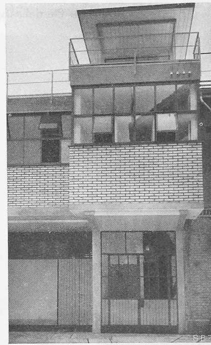
Abb. 12. Treppeneingang und Ausbau für WC.
