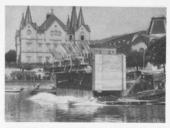
Abb. 14. Stapellauf eines Tauchwand-Schwimmkastens.
