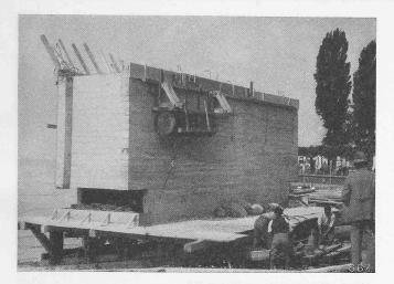
Abb. 13. Schwimmkasten (vergl. Abb. 2) auf der Helling.
