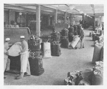
Abb. 5. Leichte ummantelte Stahlsäulen im obersten Geschoss.
