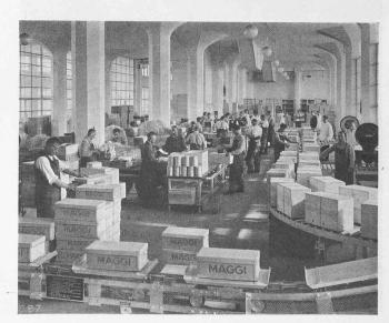
Abb. 8. Verpackung, rechts Spedition im Erdgeschoss. Pilzdecken.
