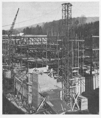
Abb. 11. Neubau aus Süden: Stahlskelett auf Eisenbeton-Unterbau.
