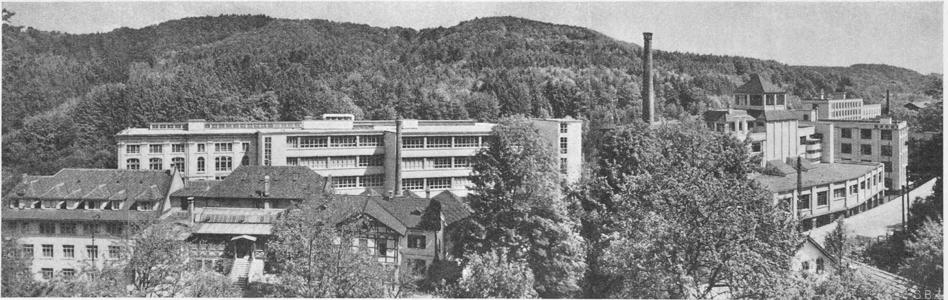
Abb. 3. Gesamtbild aus Westen: Links Verwaltung, dahinter Altbau, rechts anschliessend Neubau; dann Erbs-Silo und Mühlegebäude.
