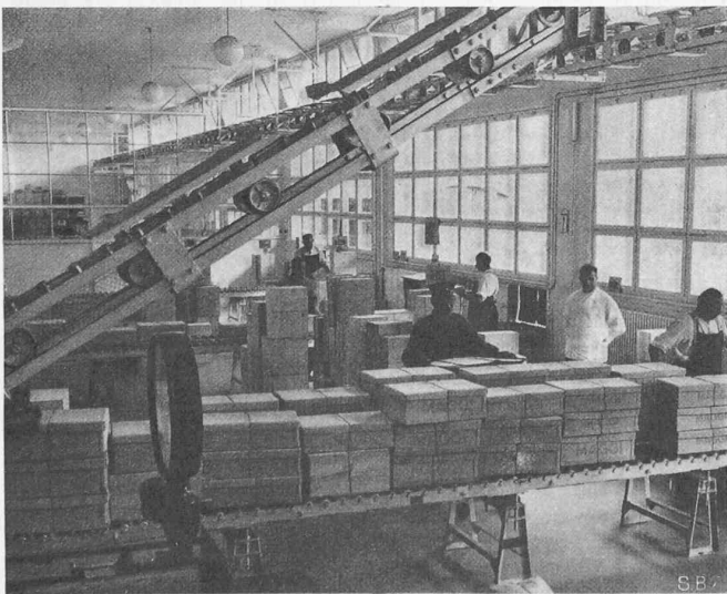
Abb. 9. Bahnamtliche Abfertigung im Erdgeschoss.
