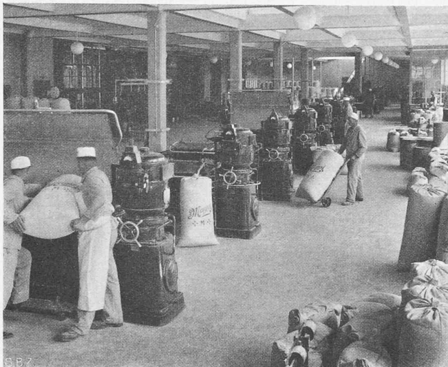
Abb. 5. Leichte ummantelte Stahlsäulen im obersten Geschoss.
