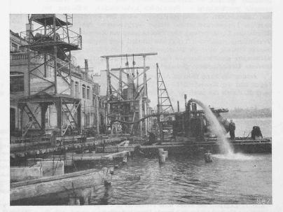
Abb. 6. Leeren der abgesenkten Caissons mit der Lauchenauerpumpe.
