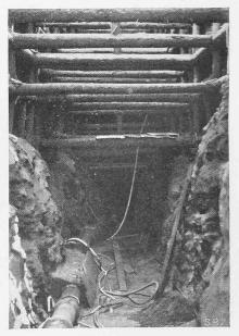
Abb. 5. Linksufriger Schutthang mit Schlitz und Einbau.
