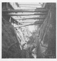
Abb. 9 und 10. Schlitz für das Einbinden des Lehmkernes unter dem geschütteten Damm.
