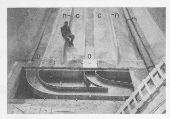
Abb. 6. Unterteil des Entsanders mit den Spülöffnungen, dem Sammelkanal und den Eisenbetonplatten für seine Abdeckung.
