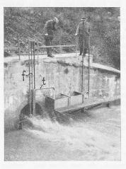
Abb. 7. Vorrichtung für die Proben-Entnahme.
