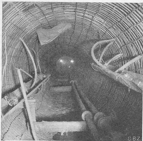
Abb. 13. Abdichtungsarbeiten im Sernfstollen.
