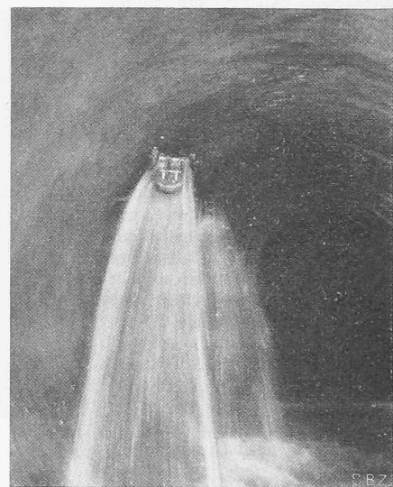
Abb. 8. Quelfassungen im mit Sika abgedichteten Stollen III-II, 330 m oberhalb W III a.
