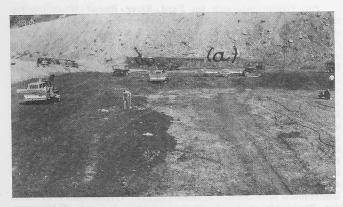
Abb. 8. Einwalzen des Dammschüttungsmaterials (Nov. 1935).
