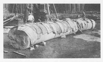
Abb. 7. Ungestörter Erdbohrkern von rd. 1 m Durchmesser.
