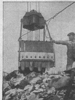
Verwendung von Stahldrahtseilen in Greifbaggern.
