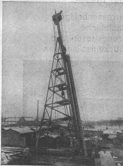
Verwendung von Stahldrahtseilen in Rammen.
