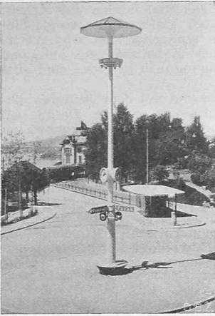
Indirekte Platzbeleuchtung: Ein Rückwurfschirm wird von Reflektoren angestrahlt und wirft ein diffuses Licht auf den Platz. Durchmesser der Verkehrsinsel 15 m (vergl. «SEV Bull.» 1934, Nr. 18).
