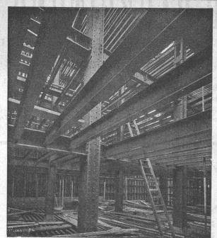
Tresorkonstruktion eines Bankgebäudes
