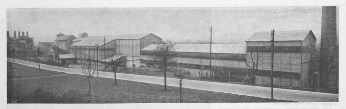
Abb. 1. Gesamtbild der Zement- und Kalkwerke Schinznach-Bad aus Nordost. Von rechts nach links: Hochkamin, Ofenhaus, Klinkerhalle mit Vorbau der Schlammsilos, Transformatorenstation, darüber Zementsilogebäude. Ganz links das alte Kalkwerk.
