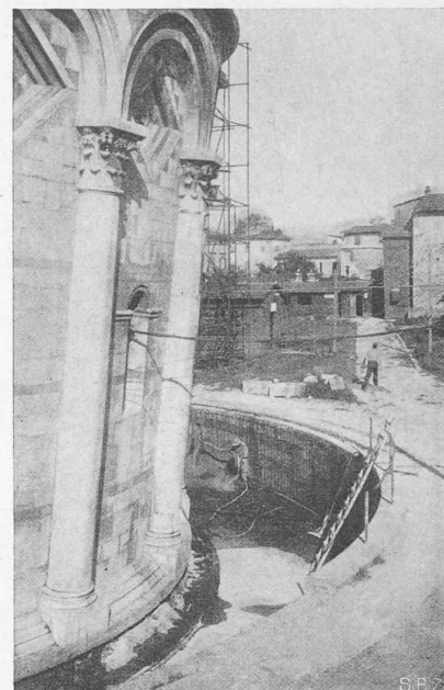
Abb. 4. Gunitierung des Ueberzuges auf der Eisenbetonbodenplatte des «Kragens». Abb. 1 und 2 aus «Bauingenieur».
