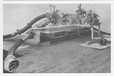
Abb. 5. Förderpumpe mit Antrieb, Saugrüssel, Ansaug-Aggregat und Injektor auf dem Versuchstand.
