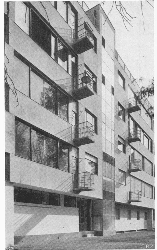
Abb. 7. Westfront mit Treppenhaus und Putzbalkonen.
