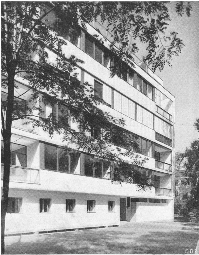
Abb. 8. Vorderfront (Ostfassade) am Zossenweg.
