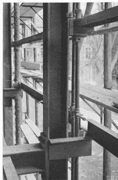
Abb. 18 bis 20. Einzelheiten der konstruktiven Durchbildung der Aussenwände. Rechts: Leitungen von der Tragkonstruktion getrennt!
