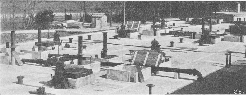
Abb. 10. Abdeckung der Faulkammern mit den Rührwerk-Motoren (links hinten die Limmat).
