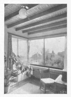
Abb. 11 u. 12. In Halle und Wohnraum: Freie Aussicht Sommer und Winter durch eiserne Schiebefenster (wie die Terrassen-Sonnenstoren nach System Illi).
