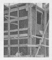
Abb. 8 und 9. Baukorkstein-Wand im Aufbau.
