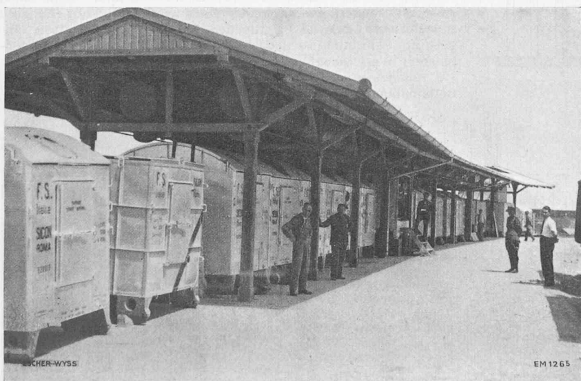
Abb. 9. Gesamtbild der nach Italien gelieferten transportablen EWAG-Kühl-Behälter-Anlage.
