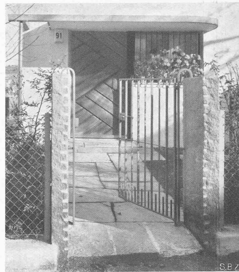
Abb. 4. Haustür. — Photos Steiner-Heiniger.
