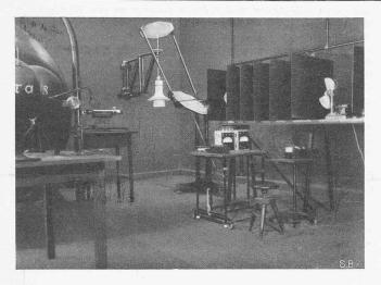
Abb. 2. Schwarzes Laboratorium. Rechts Photometerbank.
