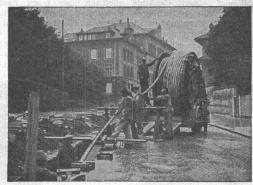
Verlegung von 6 kV Kabeln 3 × 240 mm² für das Elektrizitätsverk der Stadt Bern. Kabelgewicht ca. 100 000 kg.
