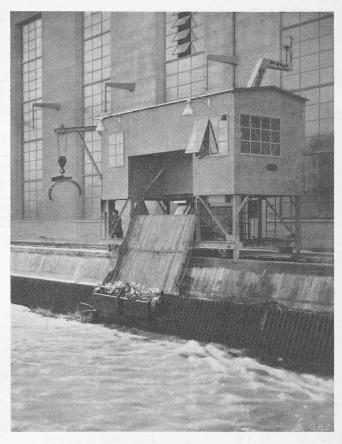
Abb. 2. Rechenreinigungsanlage beim Aarekraftwerk Klingnau.
